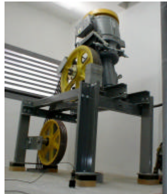
Figura 3.1: Esquema de un ascensor electromecánico (izquierda). Foto de ascensor máquina arriba en edificios con duplex (derecha).
